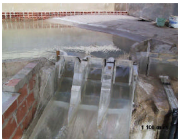
Funcionamento da soleira descarregadora
