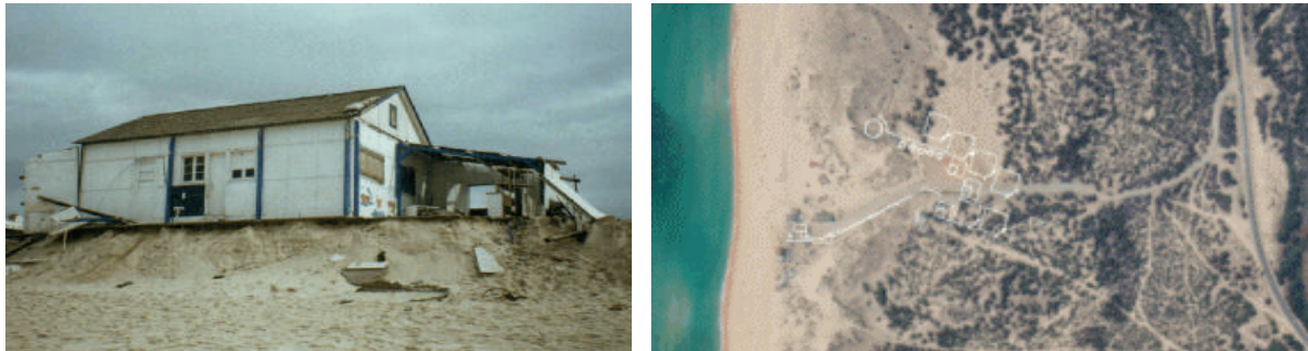
Figura 7 – Restaurante atingido pelo mar (Praia da Comporta) e futura localização (recuada) das infra-estruturas e equipamentos.
