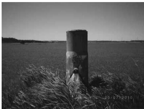
As tomadas de água encontram-se, geralmente, colocadas na parte superior central de cada parcela, junto ao caminho que a delimita, permitindo assim um fácil acesso à água e possibilitando as necessárias operações de manutenção e fiscalização, bem como a manobra das válvulas.
