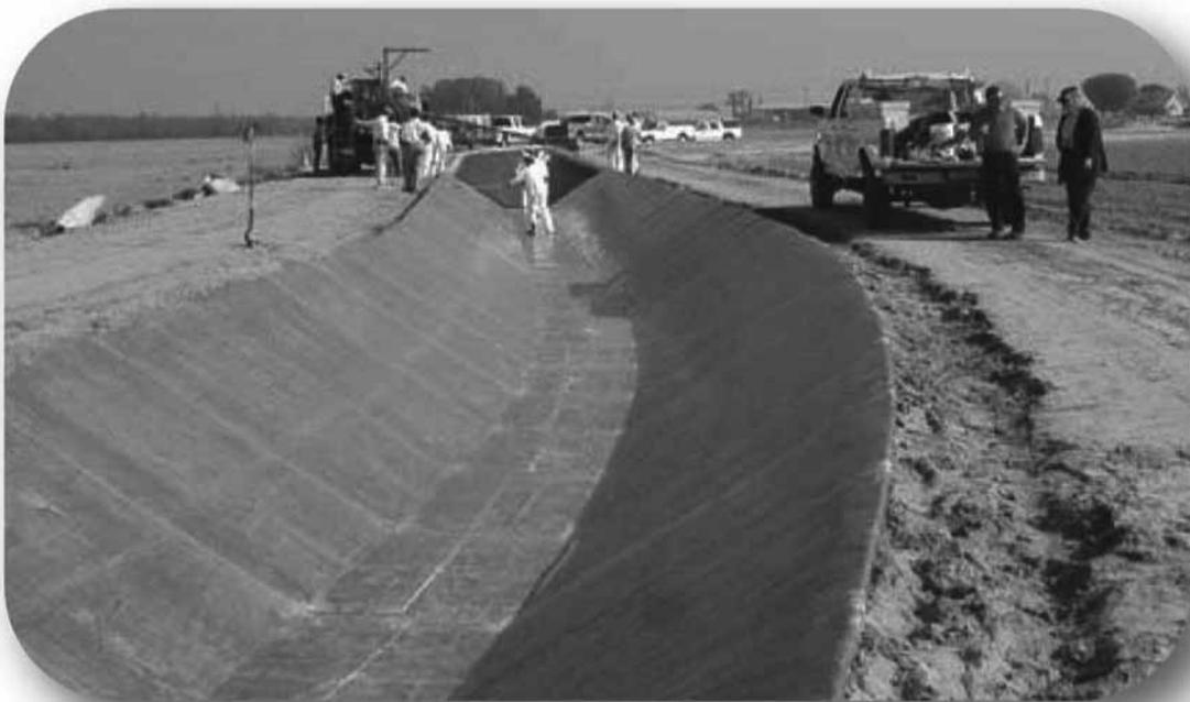
Figura 15 - PROJECÇÃO DE POLIURETANO SOBRE GEOTÊXTIL
