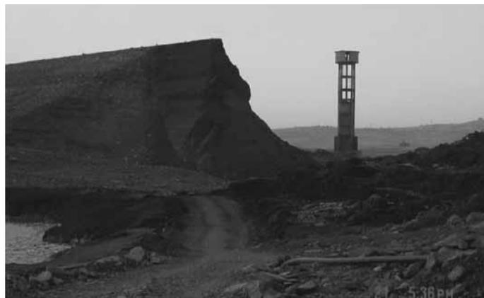
Figura 3 - Ruptura da barragem de Zeyzoun, na Síria
