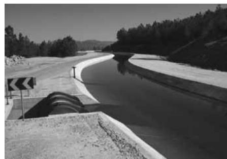
Fotografia 6 - 2º troço do canal condutor geral. Em construção e já em carga
