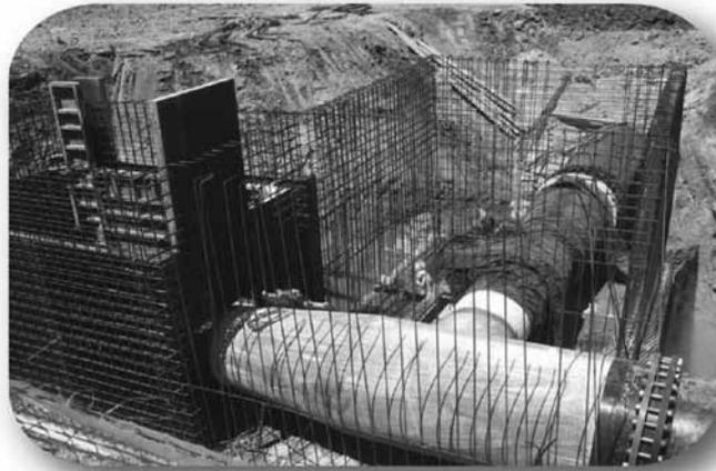
Fotografia 28 – CAIXA DE DERIVAÇÃO E DESCARGA DE FUNDO
