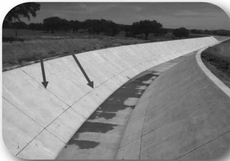
Fotografia 17 - CANAL DE BETÃO COM JUNTAS LONGITUDINAIS E TRANSVERSAIS
