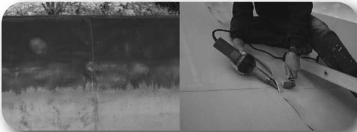
Fotografia 12 - JUNTA ENTRE MEMBRANAS DE POLIETILENO E EXECUÇÃO DE UMA JUNTA ENTRE MEMBRANAS DE PVC
