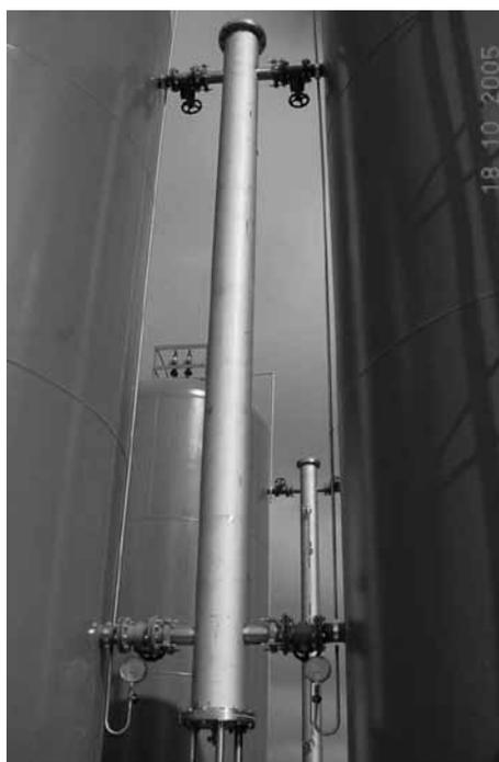
Figura 30 - Barrilete e manómetro dos RACs
