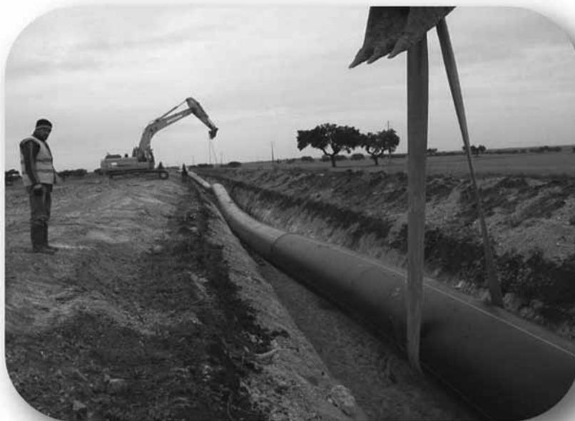
Fotografia 23 – TUBO EM PEAD (coloca-se com cintas após soldadura fora da vala)
