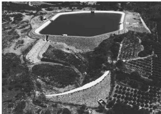
O Reservatório, com uma capacidade de 130 000 m<sup>3</sup> entre as cotas (100,0) e (105,0) (coroa-mento à cota 106,0) tem autonomia para 8 horas de abastecimento da ETA de Tavira, e permite dispor de um volume correspondente a cerca de 50% do consumo de rega diário dos Blocos D4.2 e D4.3.
