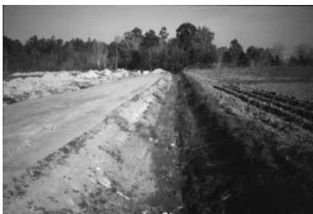
O dimensionamento desta rede de drenagem foi definido de acordo com os seguintes critérios de drenagem: o escoamento de um caudal udométrico de 2,5 l/s/ha e a manutenção de um plano de água com uma profundidade mínima de 0,60 m.
