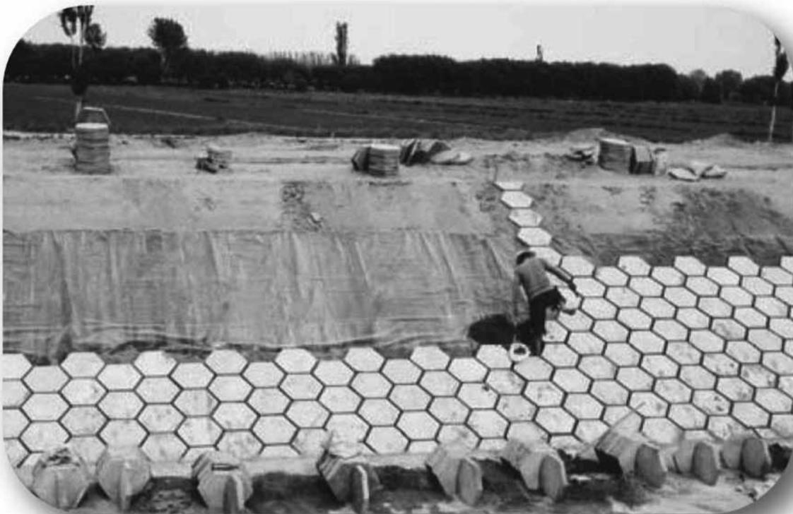
Fotografia 11 - MEMBRANA DE PVC PROTEGIDA COM LAJETAS
