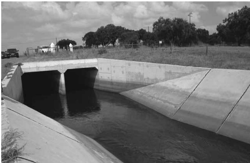
Fotografia 9 – Canal Alvito – Pisão. Transição entre o canal a céu aberto e o troço coberto
