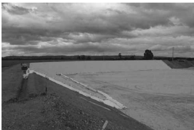
4. Pormenor da ancoragem da tela (que pode ser feita com uma viga de betão ou só com o solo – como é o caso que se exemplifica) e o reservatório após ter terminado a colocação da tela e procedido à soldadura dos diversos painéis, entre si.
