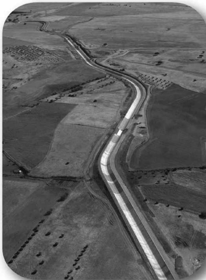
Fotografia 1 –CANAL EM PLANTA (ver um troço em que a sua betonagem foi interrompida para se efectuar uma obra localizada)
