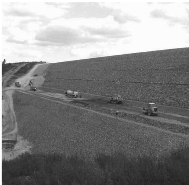
No âmbito da ampliação foram aplicados cerca de 386 000 m<sup>3</sup> de enrocamento, 22 000m<sup>2</sup> de geomembrana e 2 500m<sup>3</sup> de betão.
