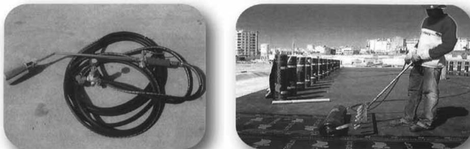
Fotografia 31 – EQUIPAMENTOS DE SOLDADURA DE MEMBRANAS ASFALTICAS)
