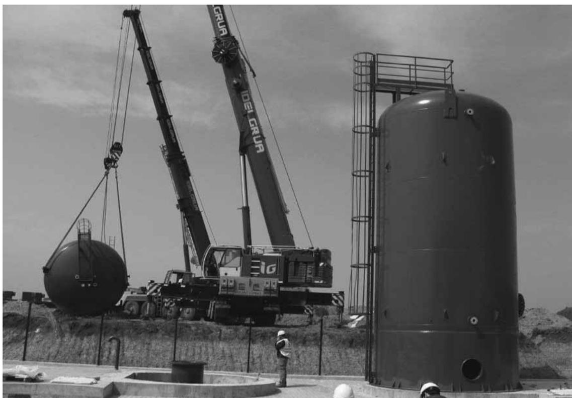
Fotografia 17 - Reservatórios Hidropneumáticos – Estação Elevatória de Brinches-Enxoé
