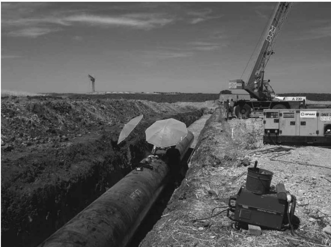
Fotografia 16 - Instalação de conduita em aço carbono – Rede de Rega de Brinches-Enxóé
