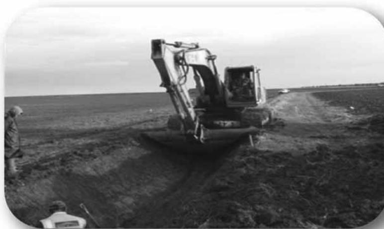
Fotografia 5 – MÁQUINA COM BALDE TRIANGULAR (para directamente se escavar a forma a revestir)
