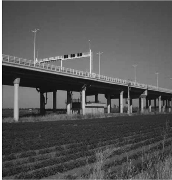
Sob a A 10, na Lezíria de Vila Franca de Xira, existe uma ETAR que recolhe as águas pluviais caídas no tabuleiro da denominada Ponte da Lezíria, as quais só são descarregadas no sistema de valas após o respectivo tratamento e separação de hidrocarbonetos, resíduos de borracha, metais pesados, etc. Tratou-se de uma exigência dos Agricultores, conscientes da importância da qualidade da água na rega das culturas praticadas na região, bem como da poluição dos solos e aquíferos.
