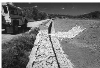
Fotografia 10 - Protecção por enrocamento
