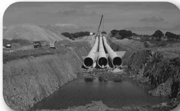
Fotografia 20 - INSTALAÇÃO DOS TUBOS DE UM SIFÃO
