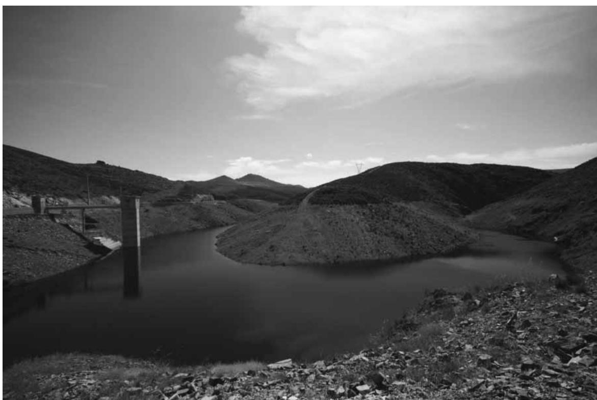
Barragem para abastecimento urbano, de betão gravidade clássica, com 34,5 m de altura máxima acima da fundação, 123 m de desenvolvimento do coroamento e 30300m<sup>3</sup> de volume de betão.
