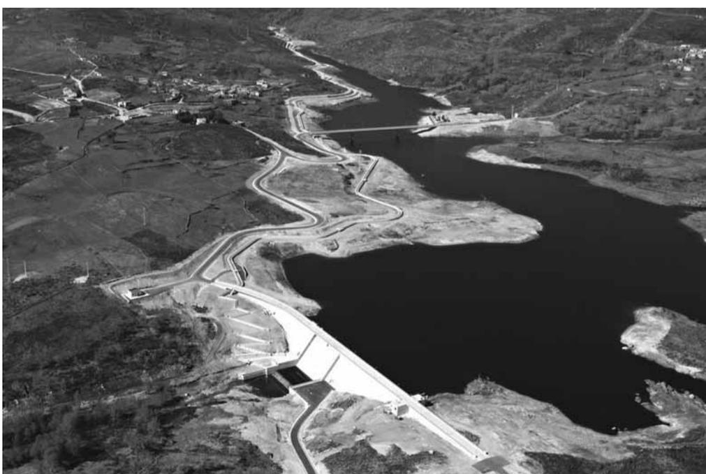
Barragem para abastecimento urbano, de betão gravidade clássico, com 28,5 m de altura máxima acima da fundação, 305 m de desenvolvimento do coroamento e 37 000m<sup>3</sup> de volume de betão.
