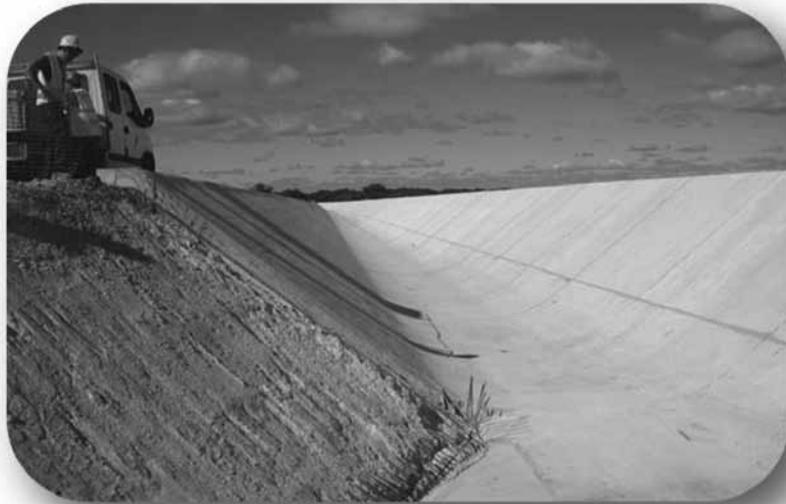
Fotografia 22 – CONSTRUÇÃO DE UMA ENTRADA EM RAMPA NO CANAL
