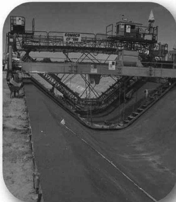
Fotografia 7 – CANAL ESCAVADO E PONTO A SER BETONADO      Fotografia 8 – COFRAGEM DESLIZANTE SECÇÃO PLENA
