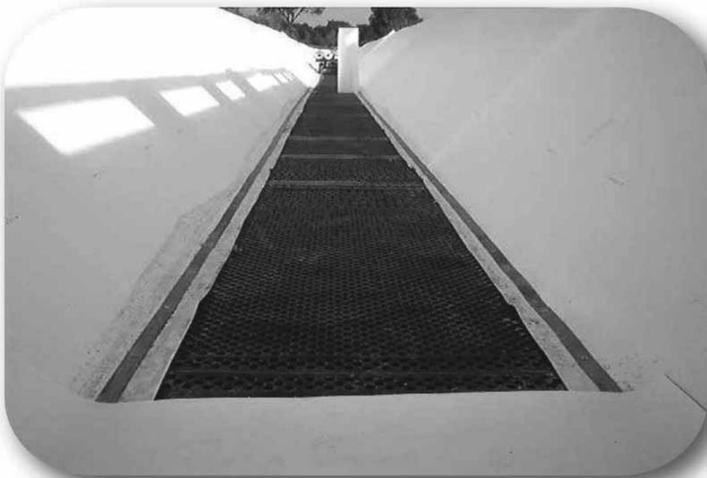
Figura 13 - FIXAÇÃO CONTÍNUA NO RASTO DO CANAL COM GEODRENO
