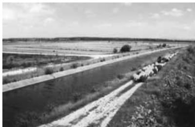
A rede primária de rega do Aproveitamento Hidráulico do Mondego é tutelada actualmente pelo Instituto da Água (INAG) e é essencialmente constituída pelo Canal Condutor Geral com um desenvolvimento de cerca de 37 km e dimensionado, na secção inicial, para um caudal de 22 m<sup>3</sup>/s.
