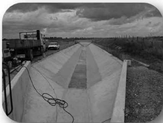
Fotografia 2 – TRANSIÇÃO PARA INSTALAÇÃO DE COMPORTA
