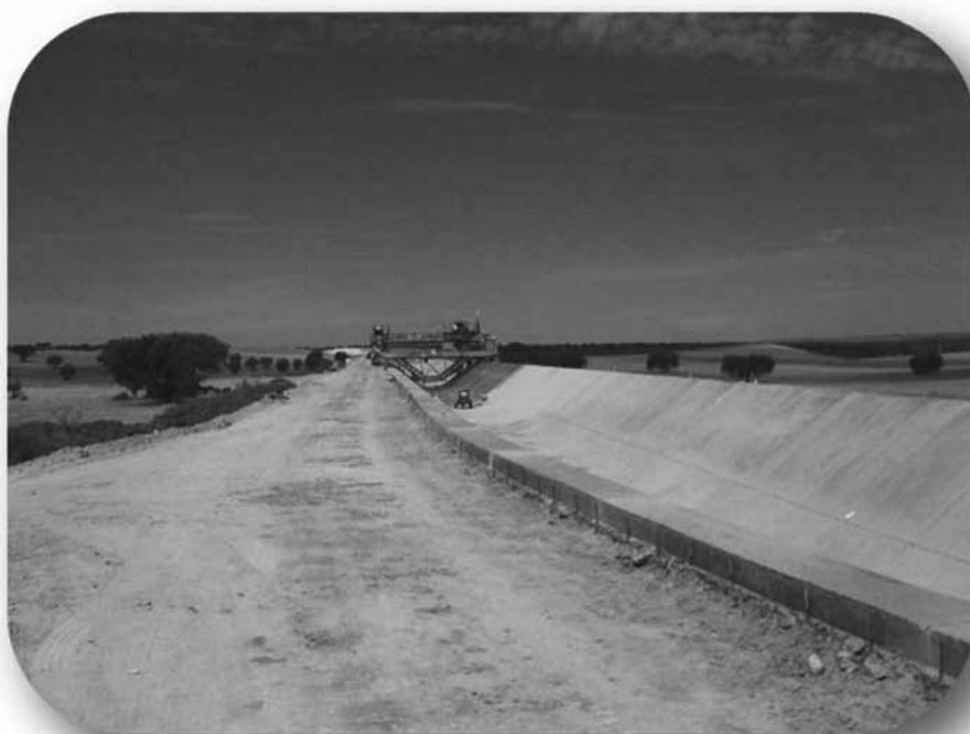
Fotografia 9 –CANAL APÓS A BETONAGEM
