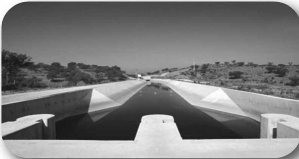
Fotografia 4 – OBRA DE ENTRADA DE UM SIFÃO (ver as ranhuras para instalação de encaadeiras de isolamento e as bóias superficiais da rede de protecção da entrada)
