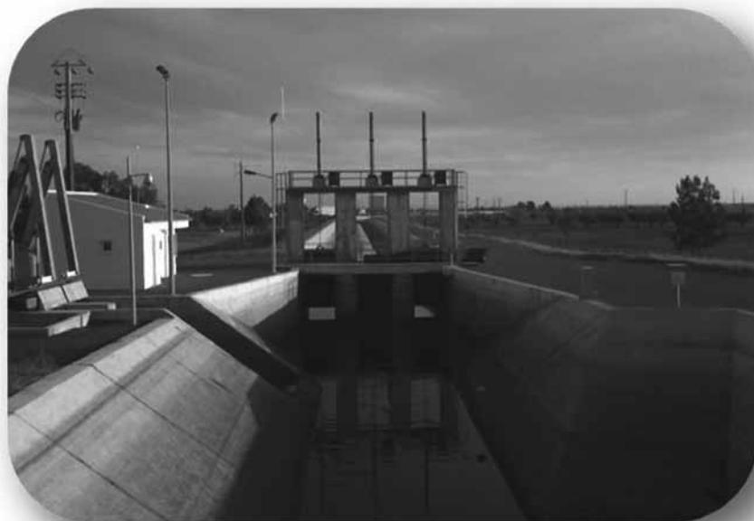
Fotografia 16 – DERIVAÇÃO NUM CANAL (comportas de regulação do escoamento e grelha com limpeza mecânica na derivação)
