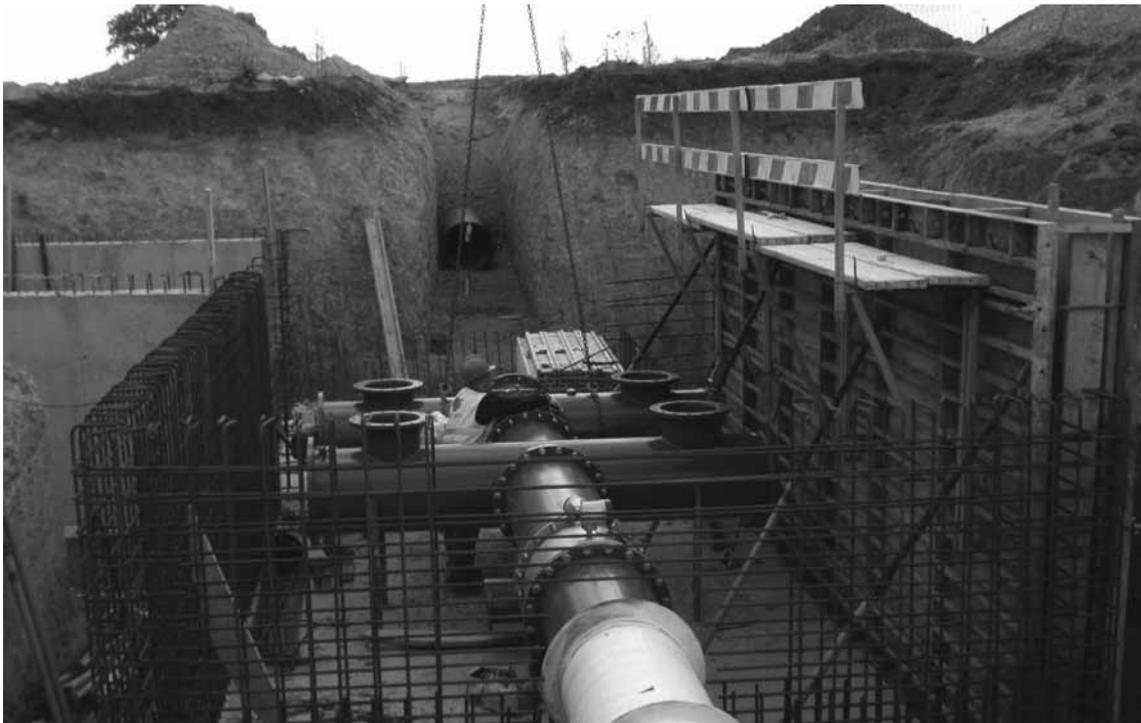
Fotografia 15 - Peças Especiais da Vican – Estação Elevatória de Brinches Enxóé
