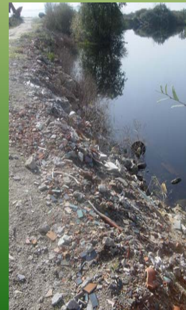
Instabilidade das margens
