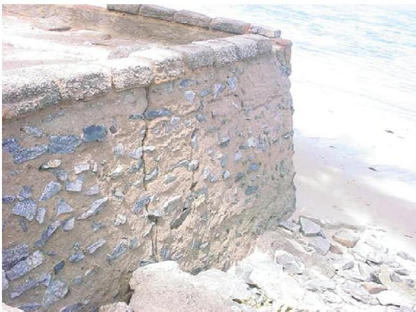
Foto 3 – Fuga do aterro do muro.
