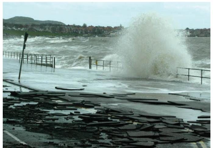
Figura 2. Estado de degradação da praia e do paredão: a) praia em condições de baixa-mar e b) galgamento do paredão.
