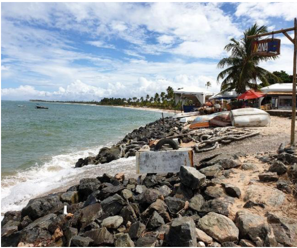
Figura 4: Estrutura de Enrocamento com pedras - Paulista/PE. Fonte: Autores (2023).
