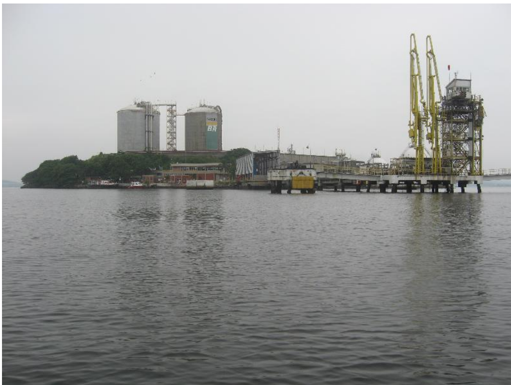
Figura 4. Terminal Aquaviário da Ilha Redonda, em São Gonçalo. Fazem-se presentes no território do município as atividades da indústria petroquímica.
