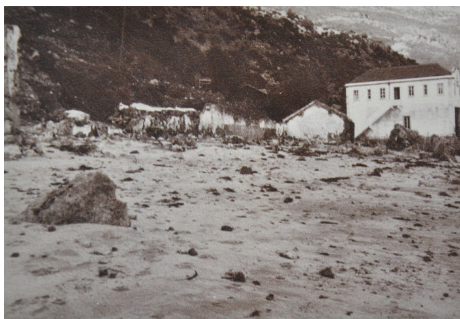
Figura 18 – Instalações do Salva Vidas, em fundo, e aspeto da destruição provocada nos anos 40, provavelmente pelo ciclone de 1941, nas construções existentes na praia (Portinho da Arrábida. 100 Anos de Memórias – Catálogo da Exposição de Fotografia. 2013).
