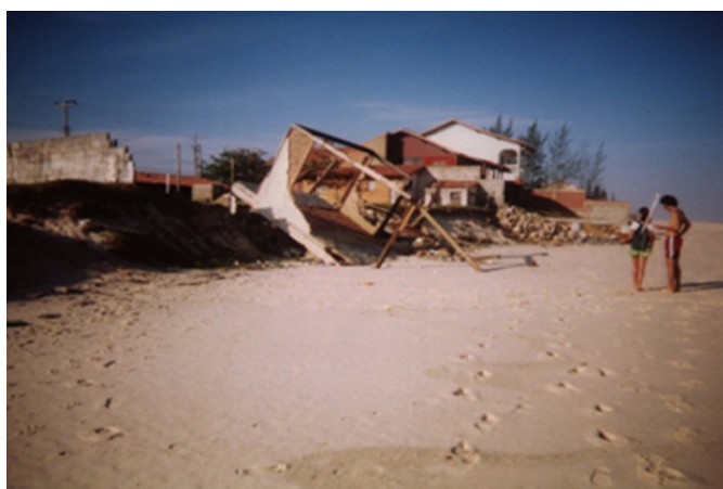
Figura 12 - Praia da Barra de Maricá após a ressaca de maio de 2001, mostrando a destruição total da Avenida Litorânea e de casas. (Foto: Dieter Muehe).
