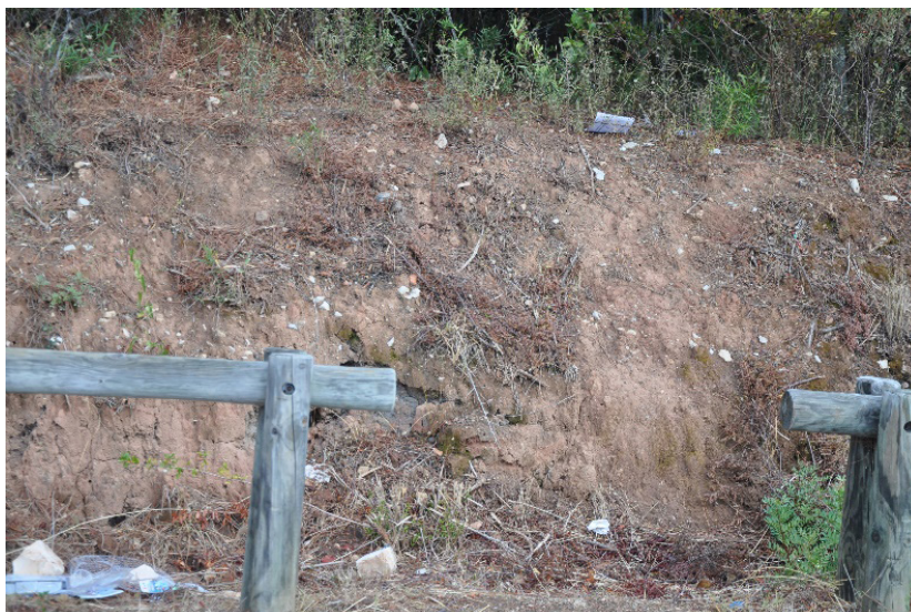
Figura 22 – Taludes gerados com a construção do parque de estacionamento (Foto datada de 13/9/2016).
