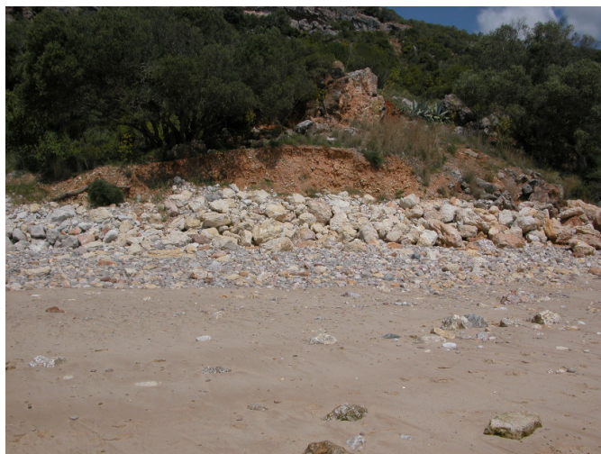
Figura 7 – Erosão costeira em depósitos de vertente. O sopé da escarpa de erosão encontra-se protegido por um pequeno enrocamento e, à frente do enrocamento, encontra-se uma praia de calhau rolado parcialmente coberta por areia (16/2/2017).
