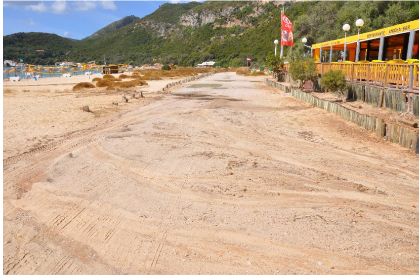
Figura 23 – Efeito negativo do caminho, construído sobre a praia do Creiro, na drenagem das águas pluviais, fazendo aumentar a secção de contato com a praia e incrementando, dessa forma, o impacte das argilas na qualidade da areia (13/9/2016).
