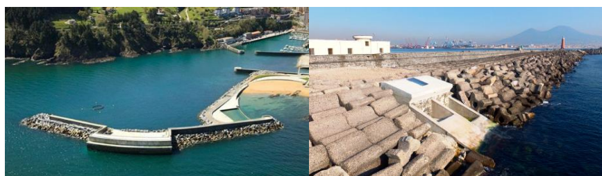
Fig. 1. Coluna de água oscilante em Mutriku, Espanha (esquerda) e dispositivo de galgamento OBREC instalado no porto de Nápoles, Itália (direita).
