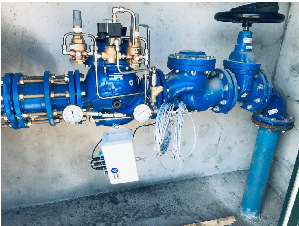
Figura 4 - ZMC com válvula Série 900 da Bermad e datalogger Célula WW da Regacom
