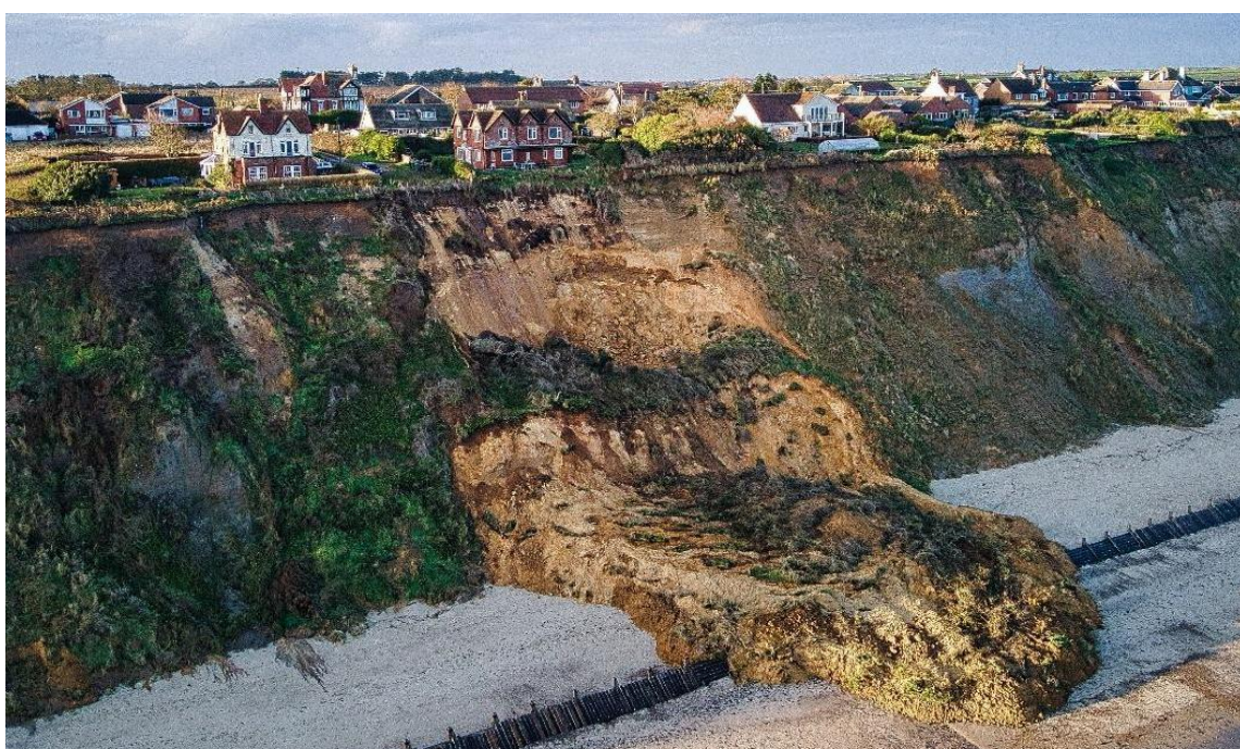
Deslizamentos de terras causados por elevadas pressões de águas subterrâneas e erosão
