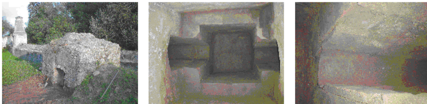
Fig. 16 – Aqueduto seiscentista. Vistas de caixa de visita e de decantação na Quinta do Serrado, notando-se à esquerda, por detrás, o aqueduto actual. A caixa apresenta uma torre cúbica, com porta de entrada e vestígios de um pináculo no topo da abóbada (P. Villas Boas, 2005).
