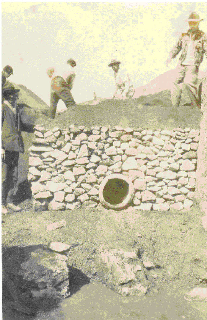
Fig. 38 – Dreno principal de captação na zona da Graça do Divo. No canto inferior esquerdo vêm-se restos do aqueduto seiscentista (CABRITA, 1928-1929) [C.M.E.].
