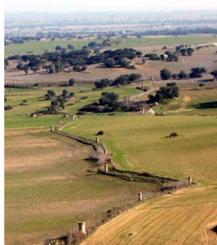
Fig. 42 – Trecho enterrado do aqueduto na zona a jusante da Graça do Divo, notando-se torres das caixas de decantação, limpeza e ventilação, construídas por Castro Cabrita (J. Mascarenhas, 2005).
