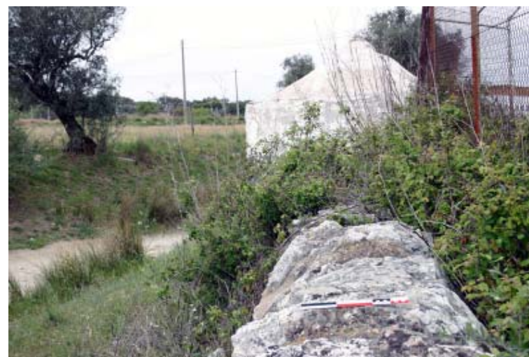
Fig. 14 – Caixas de visita e de decantação e trecho do aqueduto seiscentista a montante da arcaria. À esquerda: caixa a cerca de 35 m a jusante da caixa n.º 240 do aqueduto actual; ao centro: caixa seiscentista restaurada no século XIX; à direita, por cima: aspecto de acesso ao aqueduto (J. Mascarenhas, 2005).
