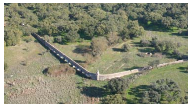
Fig. 32 – Aqueduto reconstruído no último quarto do século XIX junto à capela da Quinta de S. José, em cima, e nas imediações da Quinta do Salgado, em baixo (J. Mascarenhas, 2005).
