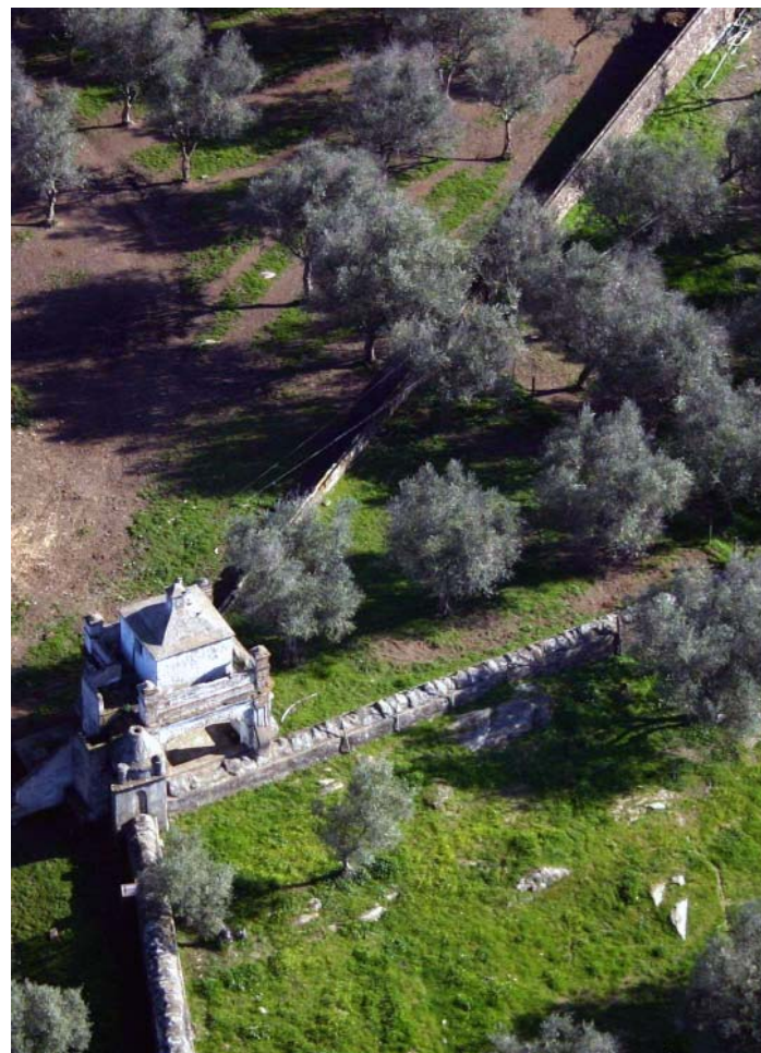
Fig. 24 – Aqueduto seiscentista. Edifício da arca de derivação para o Convento da Cartuxa e, à direita, continuação do aqueduto para Évora (J. Mascarenhas, 2005).
