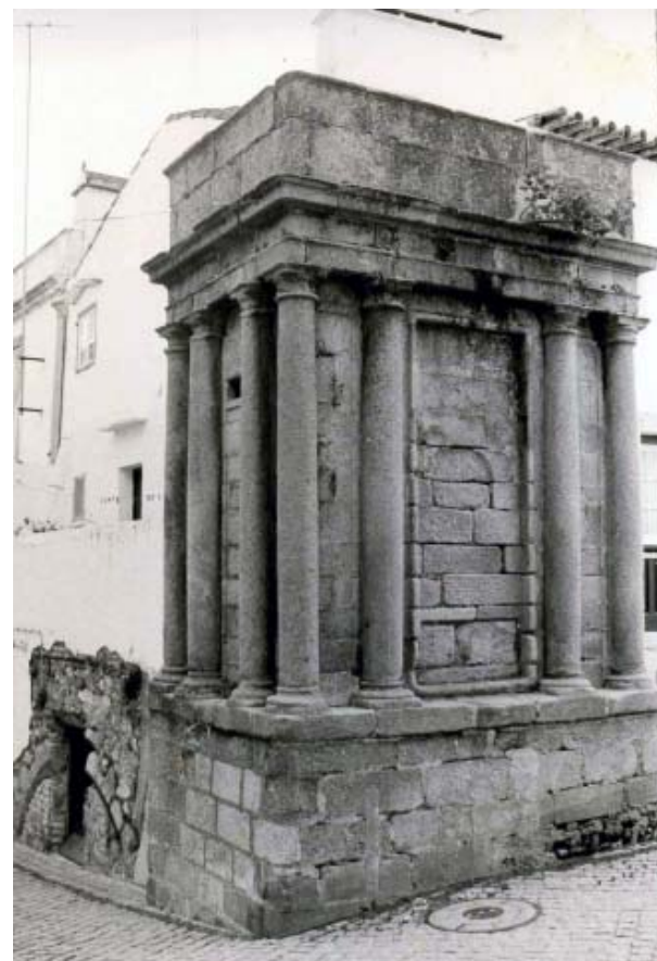
Fig. 23 – Arca de água, na Rua Nova, para decantação e distribuição, construída por Francisco de Arruda, notando-se, no canto inferior esquerdo, parte de arco de aqueduto de derivação.
