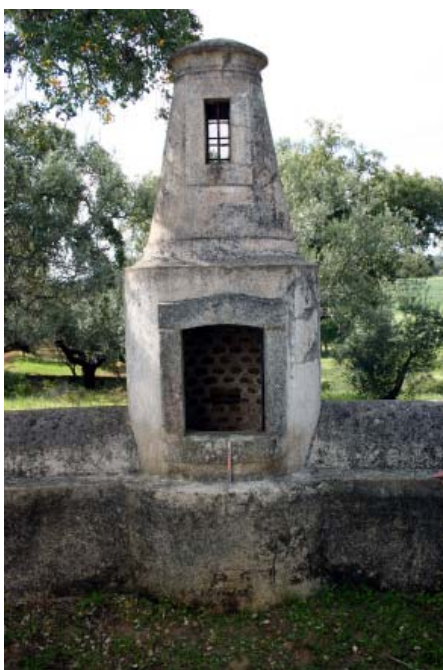
Fig. 33 – Aqueduto na Quinta de S. José reconstruído no último quarto do século XIX. Caixa de decantação e de visita com vista do exterior e vistas do interior, mostrando a entrada para o desvio da água ( by-pass ), durante a limpeza (J. Mascarenhas, 2005).
