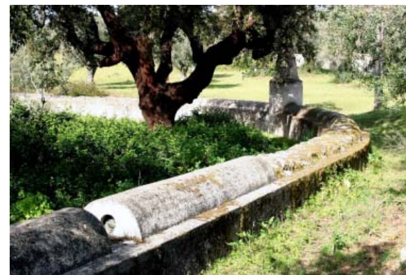
Fig. 31 – Aqueduto na Quinta de S. José (reconstrução de 1873 a 1879), notando-se, à direita, cobertura por abóbada de tijoleira ou por cascões e, no canto esquerdo, ralo de arejamento (J. Mascarenhas, 2005).
