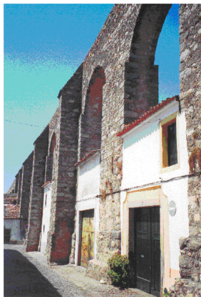
Fig. 21 – Aqueduto seiscentista, na Rua do Cano, com vãos entre os arcos preenchidos por pequenos edifícios.
