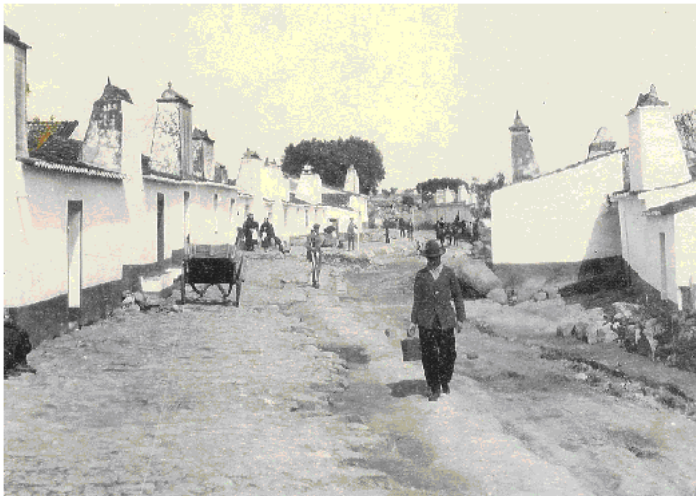
Fig. 41 – Aqueduto servindo de pavimento à rua principal da aldeia da Graça do Divo antes de ter sido desviado por sifão invertido), em 1930 (CABRITA, 1928 – 1929) [C.M.E.].
