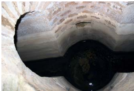
Fig. 33 – Aqueduto na Quinta de S. José reconstruído no último quarto do século XIX. Caixa de decantação e de visita com vista do exterior e vistas do interior, mostrando a entrada para o desvio da água ( by-pass ), durante a limpeza (J. Mascarenhas, 2005).
