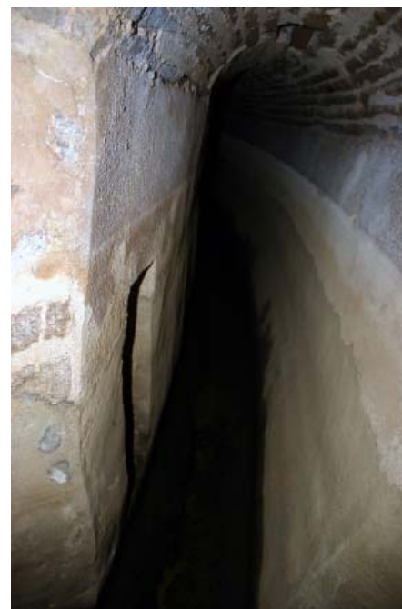
Fig. 33 – Aqueduto na Quinta de S. José reconstruído no último quarto do século XIX. Caixa de decantação e de visita com vista do exterior e vistas do interior, mostrando a entrada para o desvio da água ( by-pass ), durante a limpeza (J. Mascarenhas, 2005).
