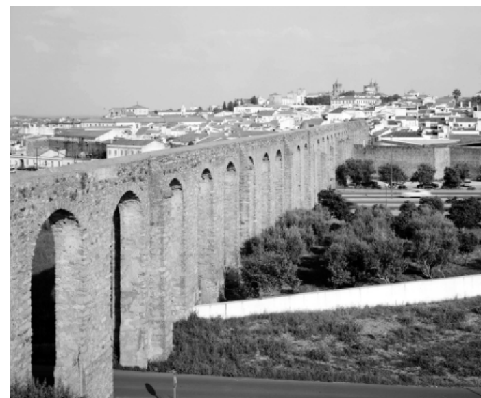
Fig. 10 – Trecho monumental do aqueduto à entrada da muralha de Évora, visto do Forte de Santo António (A. Passaporte, década de 1960) [A.F./C.M.E.].
