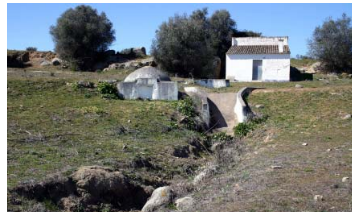
Fig. 45 – Pormenores do aqueduto, cerca de 500 m a montante da Quinta do Pátio da Oliveira: revestimento por placa de betão para protecção contra a erosão; caixa de decantação e limpeza (J. Mascarenhas, 2005).
