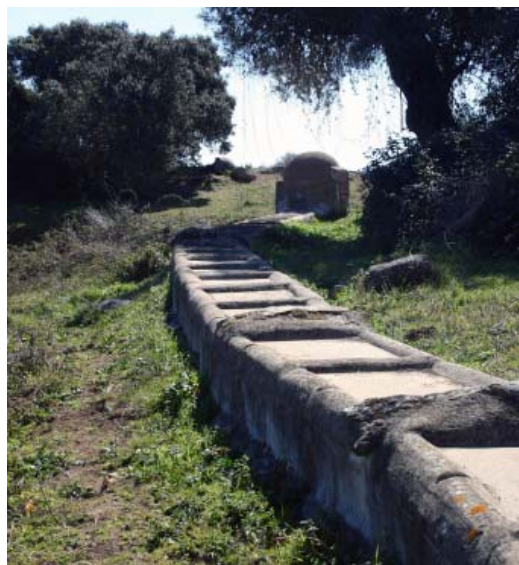
Fig. 44 – Trecho do aqueduto com cobertura por placas de betão, construção de Castro Cabrita ou posterior (J. Mascarenhas, 2005).
