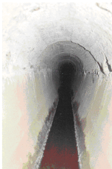
Fig. 43 – Aqueduto com secção ovóide de bico para baixo, na zona do Divor, construído por Castro Cabrita (P. Sarantopoulos, 2005).
