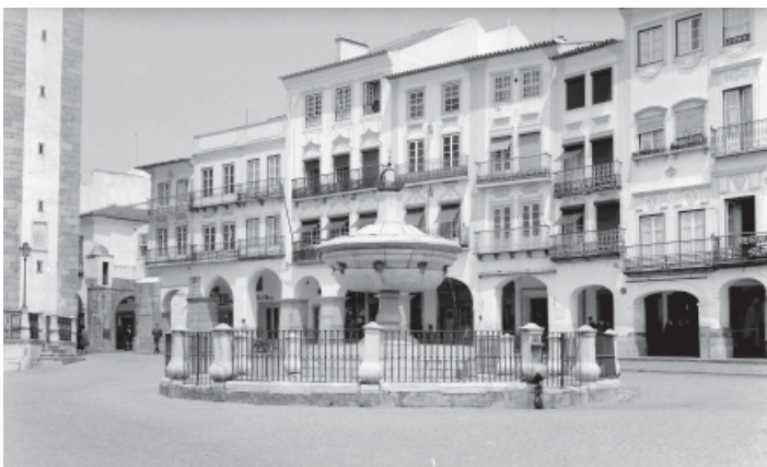
Fig. 26 – Fonte da Praça do Geraldo, notando-se, ao fundo, à esquerda, a torre de queda, encimada por caixa de água para alimentação daquela fonte (A. Passaporte, década de 1960) [A.F./C.M.E.].
