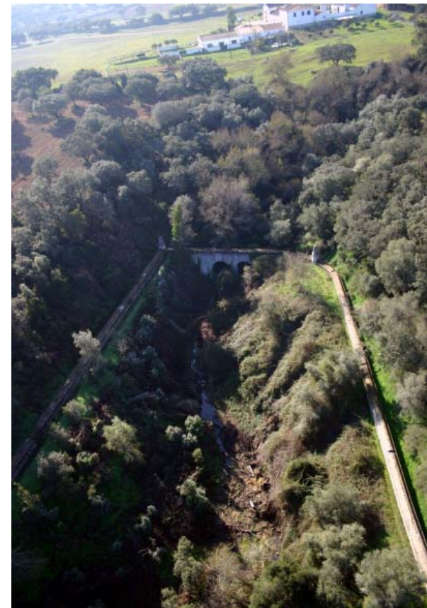
Fig. 34 – Aqueduto reconstruído no último quarto do século XIX, no atravessamento do ribeiro de Pombal (J. Mascarenhas, 2005).
