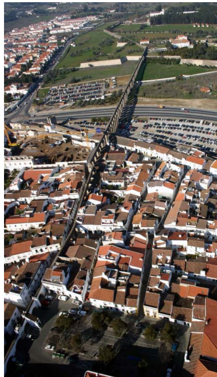
Fig. 20 – Entrada do aqueduto na malha urbana de Évora: trecho entre o Convento da Cartuxa e o Chão das Covas (J. Mascarenhas, 2005).
