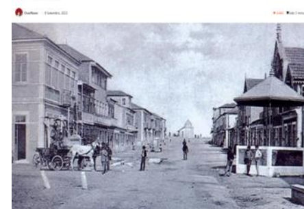
O avanço do mar derrubou a Capela Velha do Furadouro em 1939
