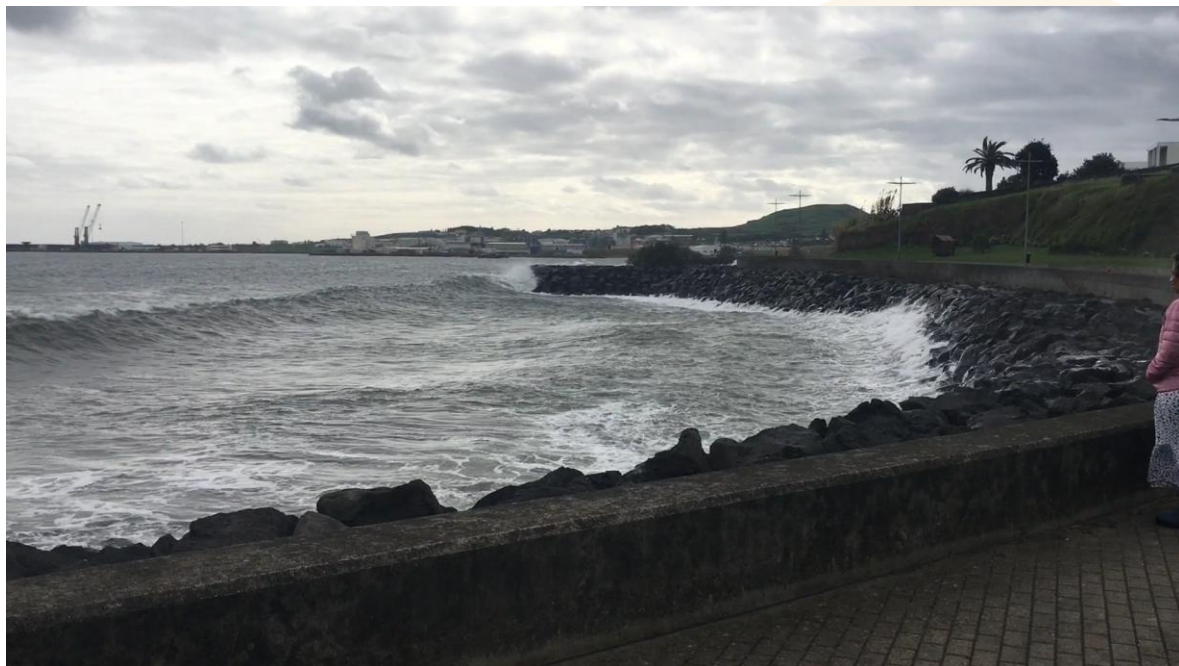
Galgamentos leves na Praia da Vitória. Data: 14 de Novembro de 2024
