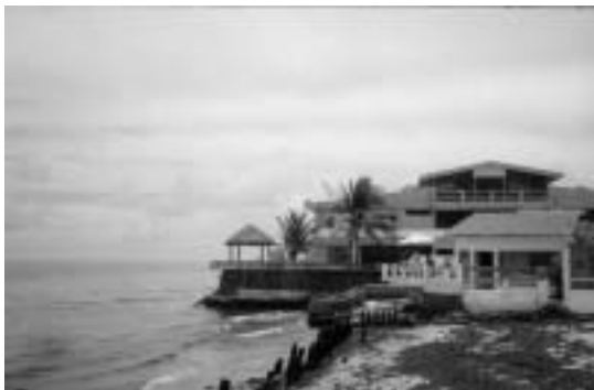
Foto 6: Trecho com alto grau de vulnerabilidade à erosão na Praia do Pilar.
