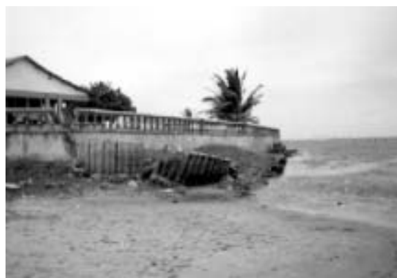
Figura 3. Erosão da margem estuarina com destruição de muros e calçadas na Prainha de Aquiraz em 2002.
