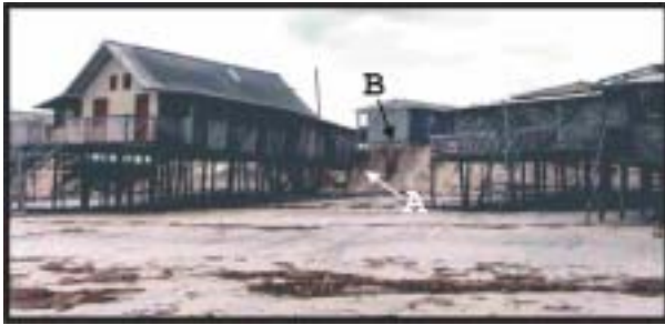
Figura 8 – Processo de erosão atuante na praia de Ajuruteua. Notar a erosão a que estão submetidas as casas (A). Escarpa de erosão causada nas dunas frontais (B). Setor II.
