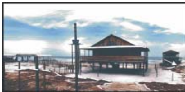
Figura 7 – Erosão causada no campo de dunas frontais, formando um leque de transposição. A seta mostra a duna rompida.
