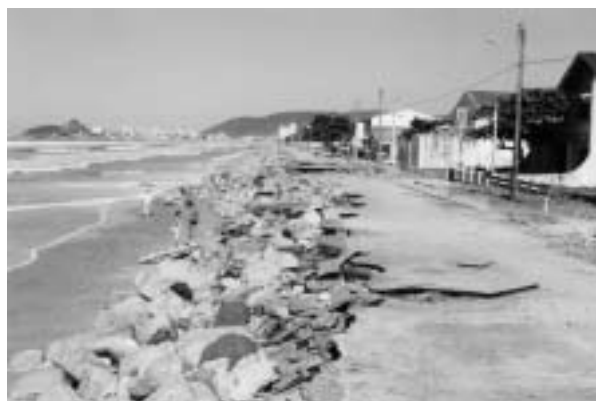
Figura 2: Enrocamentos construídos no Balneário Flamingo em frente à Avenida Beira-Mar.
