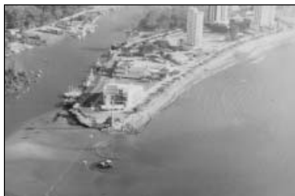
Foto 1 – Vista panorâmica da barra do rio Camboriú com a draga em operação e o aterro em construção.
