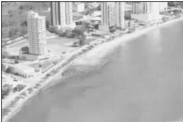
Foto 2 – Vista panorâmica do aterro da praia Central de Balneário Camboriú
