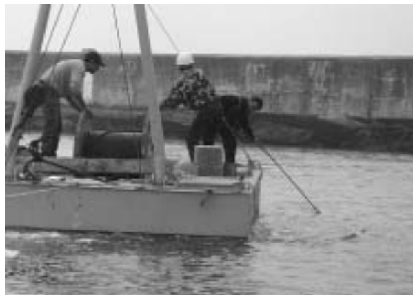
Figura 9 – Fase da instalação do cabo eléctrico no canal da embocadura.
