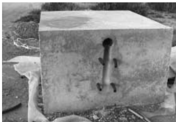
Figura 11 – Maciço de cimento, com cavidade para instalação de um eléctrodo.
