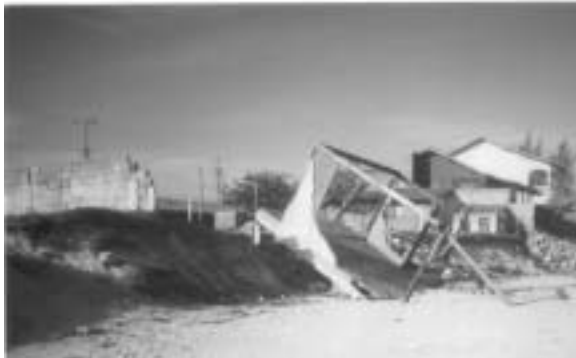
Fig. 4. Impacto classificado como forte. Destruição total da casa. (Foto D. Muehe)
