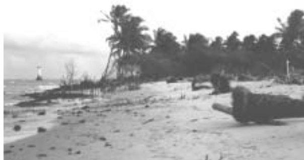
Foto 3. Erosão da praia do Cabeço na margem direita do delta do rio São Francisco
