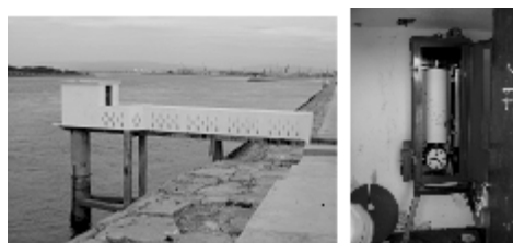
Figura 5 – À esquerda encontra-se a estrutura que aloja o marégrafo da Barra de Aveiro, na embocadura da Ria, e à direita está o marégrafo que se encontra instalado nessa estrutura.
