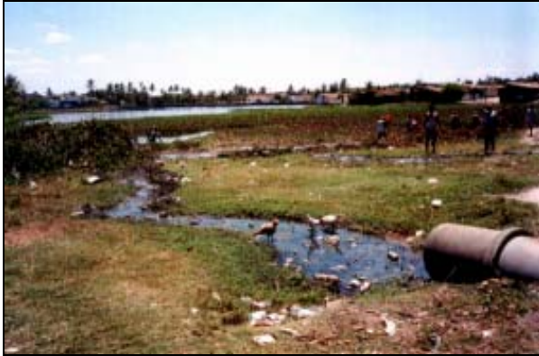
Figura 2 – Foto de uma saída de esgoto que deságua na lagoa e retirada dos aguapés à direita (ponto de coleta LC4) .
