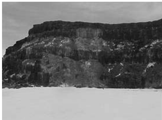
Figura 9 – deslizamento seguido de acúmulo do material no pé do “Chapadão”.
