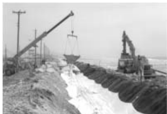
Figura 5 - Início do Enchimento do Tubo de Geotêxtil mediante uso do Funil.
