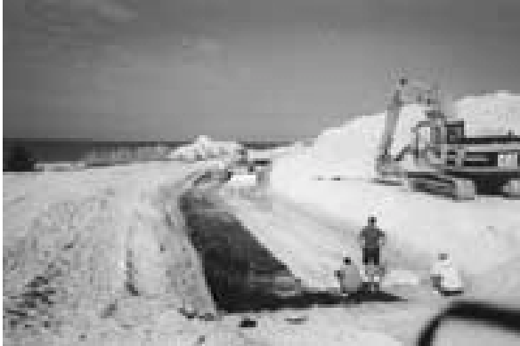
Figura 3 - Extensão do Tubo de geotêxtil Sobre a Tela Ante-erosão
