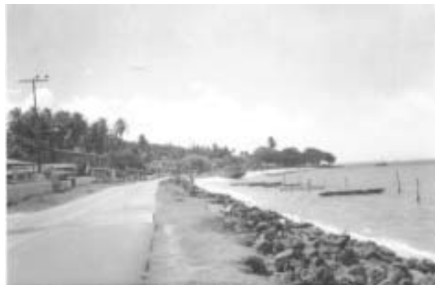
Foto 02 – Enrocamento de proteção no trecho estuarino
