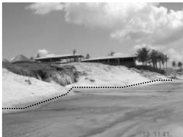
Figura 5. Construção do Hotel Absolut Resort nas dunas frontais de lagoinha. O que promoveu em um curto espaço de tempo o avanço da linha de preamar de sizígia.
