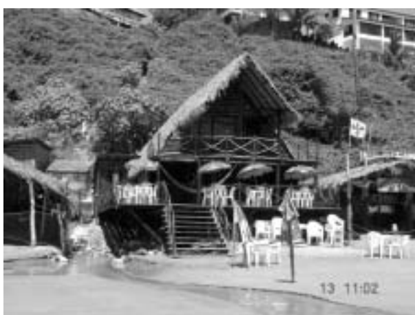
Figura 4. Barracas e bares construídos no estirâncio na forma de palafitas para evitar os efeitos erosivos das ondas nas estruturas.
