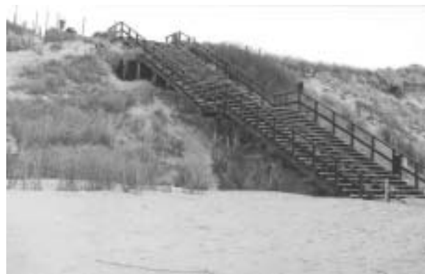
Figuras 3 e 4 – Estruturas de protecção de vegetação e escadas sobreelevadas.
