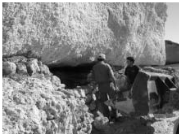
Figuras 7 e 8 - Muro de contenção de solos e enchimento de cavidades.
