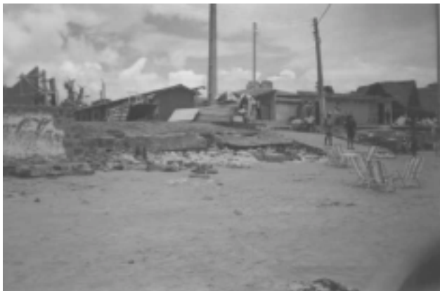
Foto 1 – Ocupação no setor da pós-praia; nota-se o muro tombado na zona de estirâncio, devido ao processo erosivo instalado.
