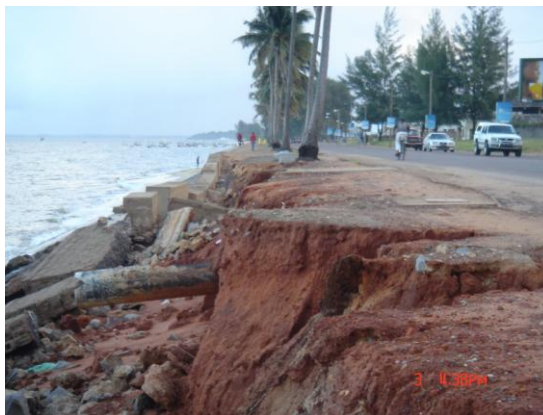
Figura 2 – Zonas costeiras evidenciando problemas de erosão: a) escarpa na duna frontal observada em 2011 a ~500 m a Norte da Ponta Mamoli (Distrito de Matutuine); b) estrutura aderente destruída na Costa do Sol (Maputo) em 2007
