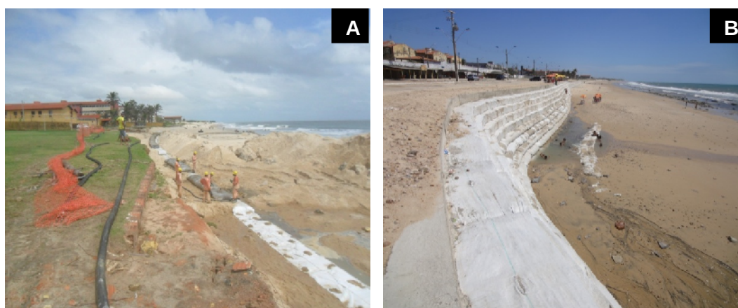
Figura 1. A) Imagens da construção do Bagwall na Praia do Icaraí. Na foto é possível acompanhar o preenchimento das geofôrmas com concreto; B) Seção construída do Bagwall paralelamente à costa contendo onze degraus a contar da base da obra (referenciada ao zero hidrográfico) até a viga de coroamento.
