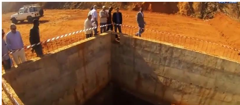
Figura 4. Caixa construída em betão pela Empresa SETE CUNHAS para o escoamento de águas pluviais (fonte SETE CUNHAS).
