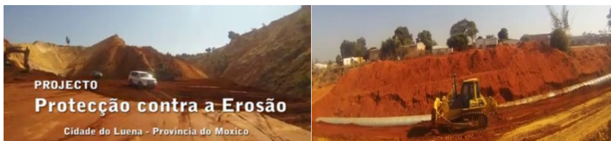
Figura 2a e 2b. Contenção de ravinas pelo método mecânico (fonte SETE CUNHAS).
