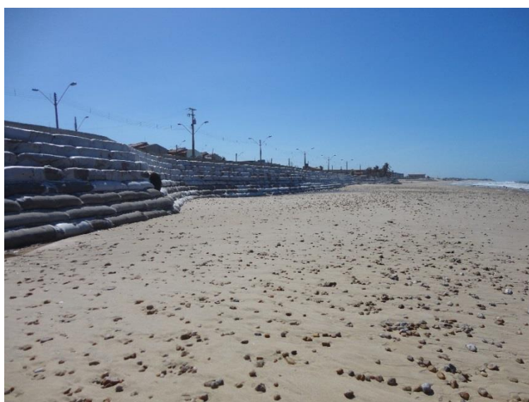
Figura 2. Dissipador de energia do tipo Bagwall construído na Praia do Icaraí, Ceará.
