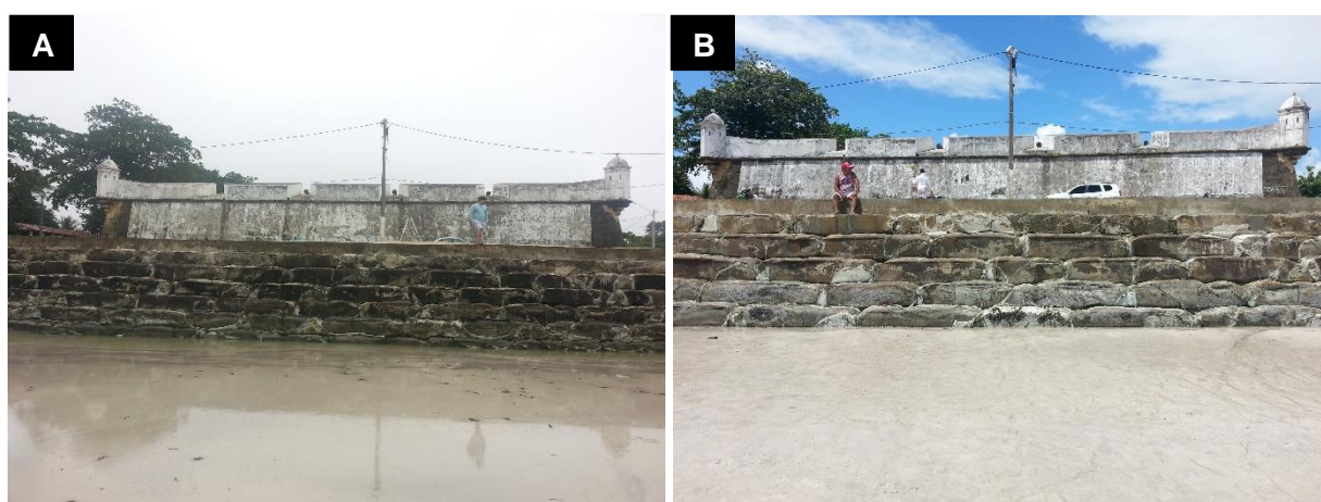
Figura 8. As imagens retratam a variação do nível de areia na base da estrutura entre os meses de julho/14 e novembro/14, indicando a baixa energia de onda e a deficiente dinâmica sedimentar.
