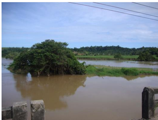
Figura 4. Rio Jitituba na ponte da Rodovia AL-105.
