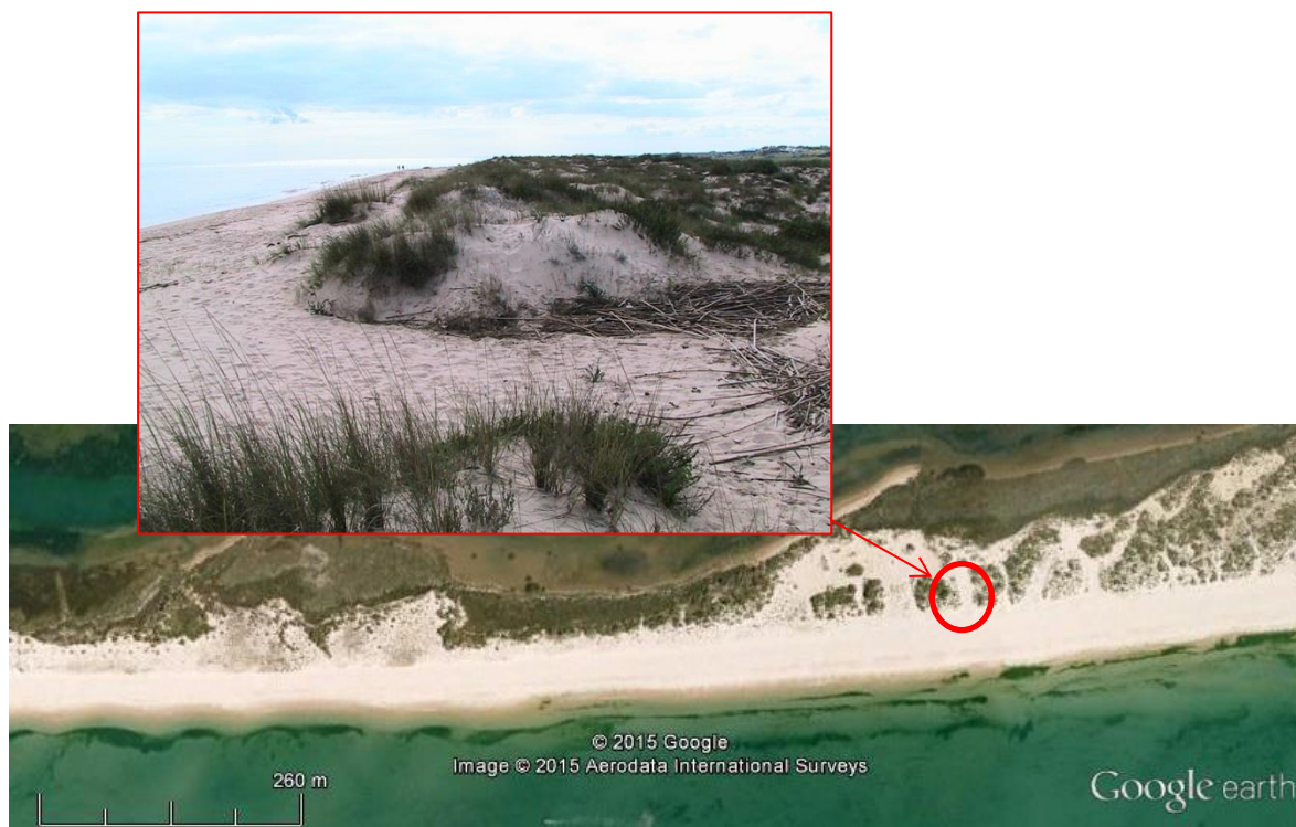
Figura 2. Cortes de galgamento da duna frontal, costa sul portuguesa.
