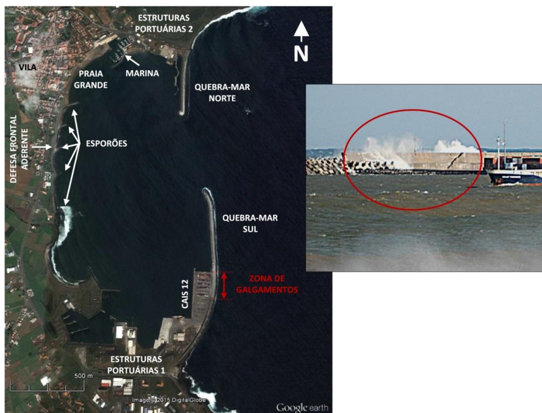
Figura 1. Porto da Praia da Vitória. Local de galgamentos (Perfil 1) (Fotografia de C. Medeiros).
