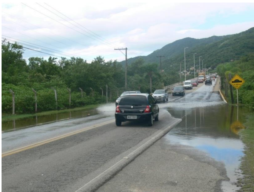
Figura 5 - Alagamento na Rod. Diomício Freitas no dia 13/03/2013, Florianópolis, SC.
