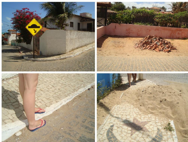
Figura 03 – Desníveis em calçadas e pavimentos e deposição de resíduos de construção que afetam a acessibilidade na comunidade de Canoa Quebrada-CE (I) Fonte: Sousa e Eloi, 2015.
