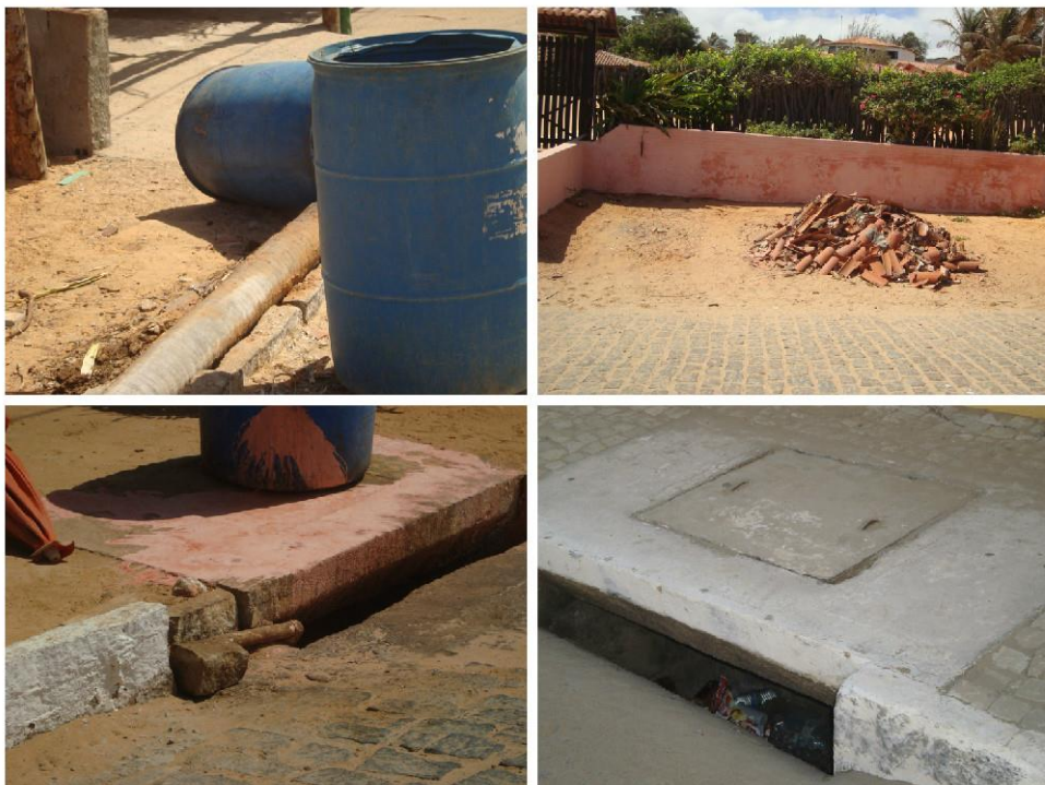
Figura 06 – Deposição de resíduos sólidos, lixeiras mal acondicionadas nos calçamentos e acúmulo de lixo nos passeios públicos.
