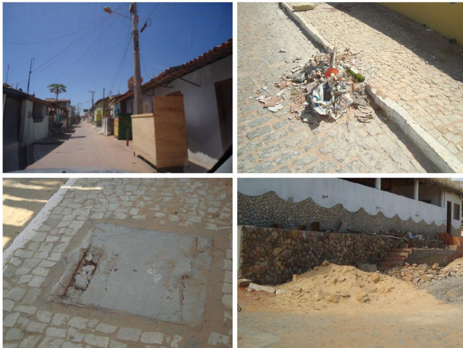
Figura 05 – Deposição de resíduos de construção e obstáculos físicos que impedem a locomoção de deficientes físicos na comunidade.
