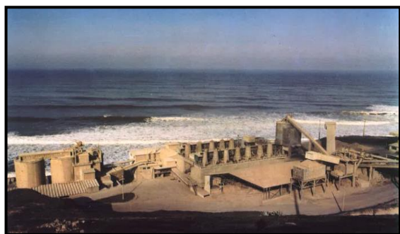
Figura 12 – Vista da fábrica de cal hidráulica do Cabo Mondego em 1997 (com 14 fornos)
