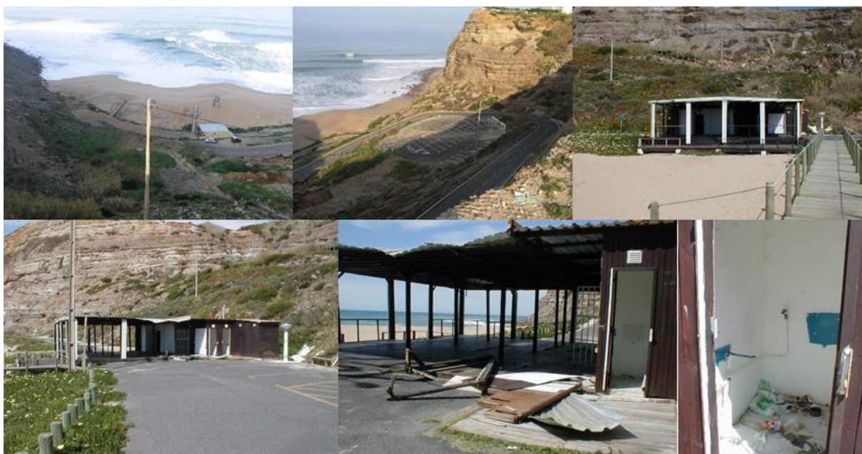
Figura 8: Antes da intervenção – Praia de Porto da Calada. Fonte: CMM.
