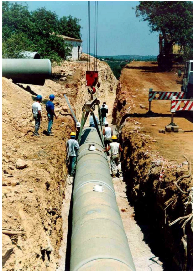
Adutor Poente – Betão Armado Pré-esforçado com Alma de Aço – DN 1200 mm
