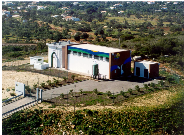
Estação Elevatória de Loulé
