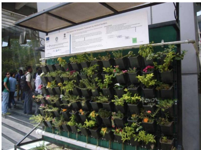
Figura 0.2 – Vista geral da parede verde piloto instalada em Pune, Índia, destinada ao tratamento de águas cinzentas provenientes de escritórios (Masi et al., 2016).
