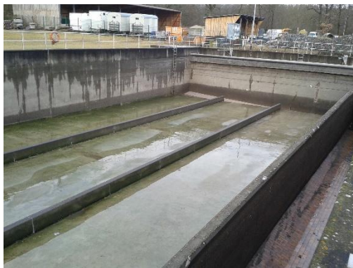
Figura 2 – Canais das bacias antipoluição: “dry weather flume” (mais à dta) e “flushing street” (à esq.).
