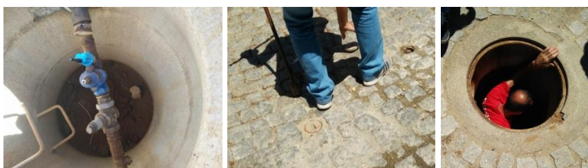
Figura Error! No text of specified style in document..4 – Instalação de loggers em válvulas de seccionamento.
