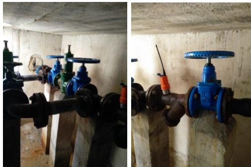
Figura Error! No text of specified style in document..2 – Instalação de um logger no que aparenta ser um sistema redutor de pressão.
