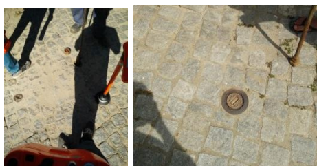
Figura Error! No text of specified style in document..2 – Instalação de um logger no que aparenta ser um sistema redutor de pressão.
