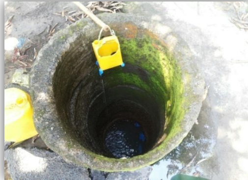
Figura2: Poço com a borda cimentada mas sem proteção.
