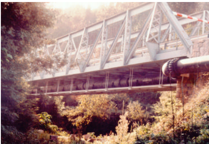
Figura 5 - Conduto elevatória EE1-EE2. Travessia sobre o rio Caima
