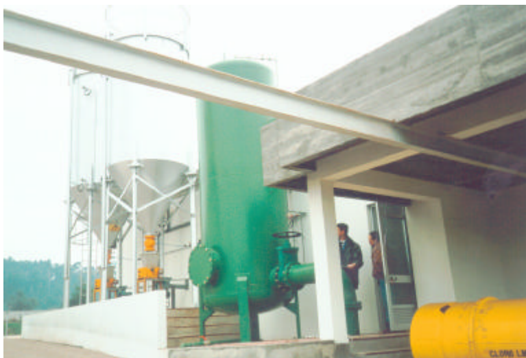
Figura 4 - Silos de cal na ETA antes das alterações
