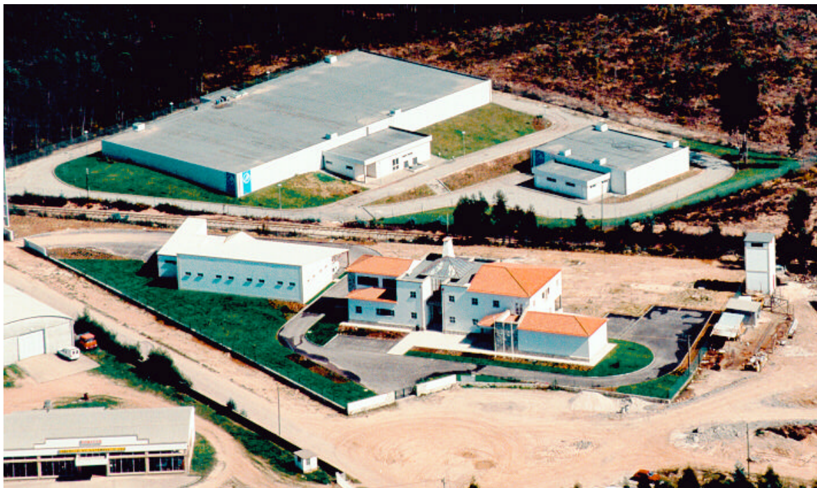
Figura 1 - Edifício de Exploração e reservatórios RPA e R2
