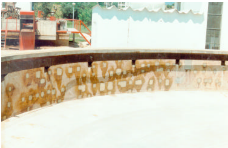
Figura 2 – Pormenor do descarregador do decantador e reparação da betonagem
