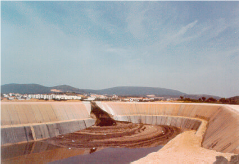
Figura 6 – Aterro controlado para deposição de lamas
