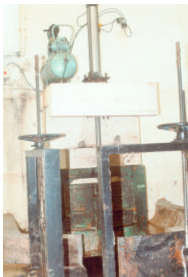
Figura 5 – Válvula de muralha à cabeça de uma estação elevatória
