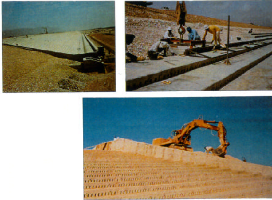
Figura 3 - Barragem de Wadi Sahalnawt, Omã. Descarregador auxiliar ( q=5,1 \text{ m}^2/\text{s} ). a) vista geral; b) fase de construção; c) degraus (extraído de MELDRUM, 1995).
