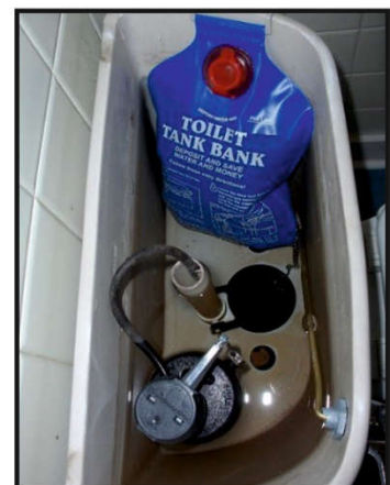
Figura 3 – Instalação de um redutor de descarga num autoclismo.
