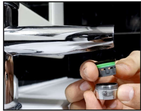
Figura 1 – Instalação de um redutor de caudal numa torneira.
