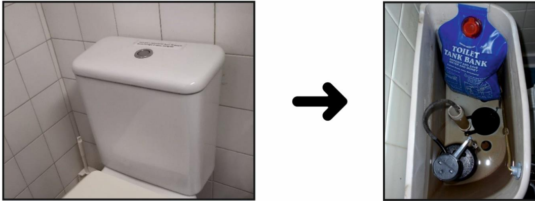
Figura 5 - Instalação de um redutor de descarga num autoclismo.
