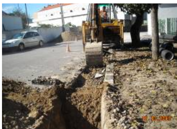
Figura 10. Intervenções na rede de drenagem de águas pluviais.
